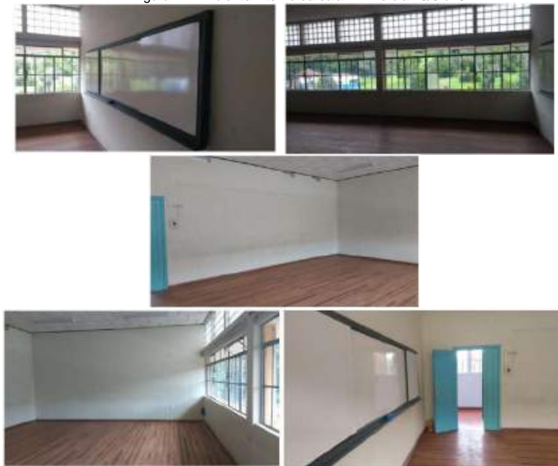
Figura 4 - Ambiente interno da sala N°1 no dia 23/02/2021.
